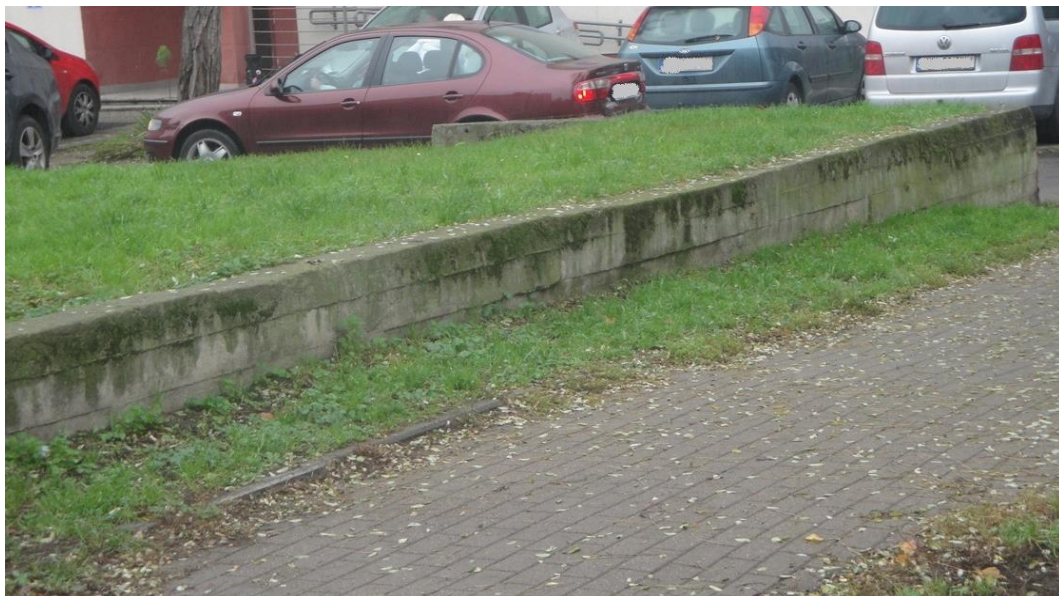
Fot.5 Mur architektoniczny (nr 6) – do rozbiórki(zgodnie z pkt.4.3 opisu) i odtworzenia przy chodniku ul. Grabowej
